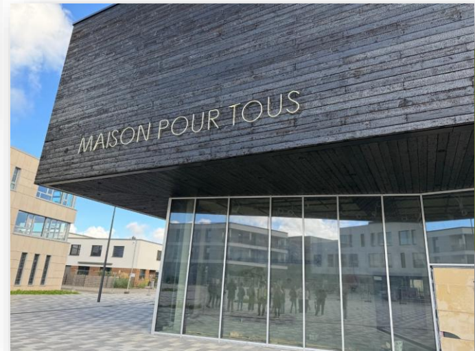
“Maison pour tous”, Quartier Elmen, Kehlen
